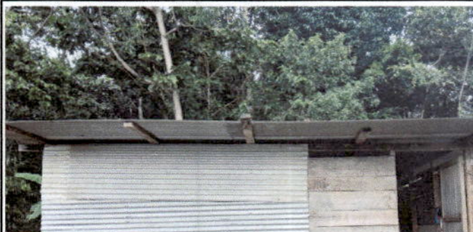
Foto 2: Sustrucción de soporte de madera por metal (Cocina)
