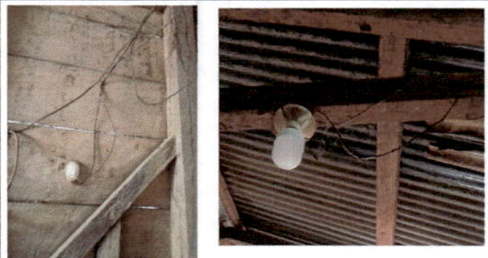
Foto 8: Reparación de sistema eléctrico
