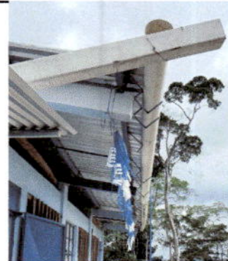
Foto 10: Reparación de bajada de agua pluvial PVC 3 y sustitución de soporte o pescante de metal
