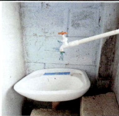
Foto 9: Sustitución de lavamanos
