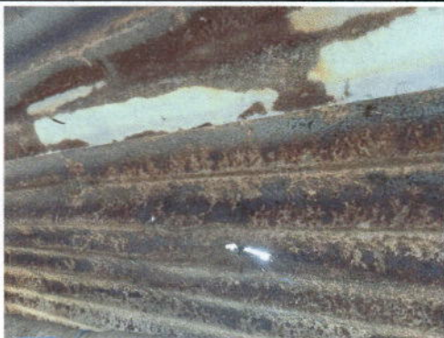
Foto1: Sustrucción de lámina, por lámina troquelada aluzic calibre 26 (Cocina)
