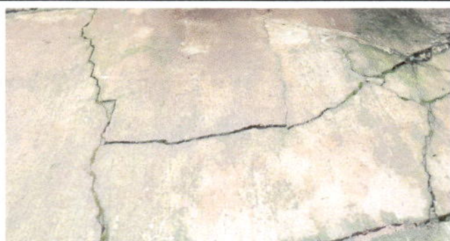
Foto 3: Sustrucción de piso de tierra por piso de torta de concreto (modulo 1 y pasillo)
