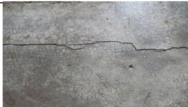
Foto 4: Sustrucción de piso de tierra por piso de cemento líquido (cocina)
